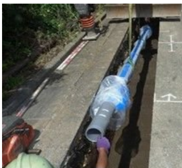
老朽管更新工事
